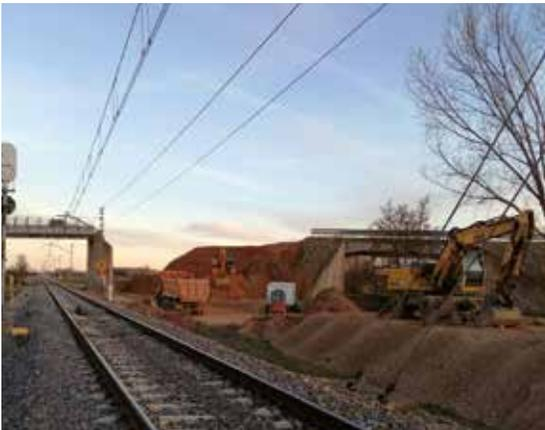
*Obras de retirada de áridos para reposición de taludes y aletas.*
